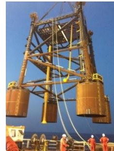
Gambar 2 Fondasi Suction pile
