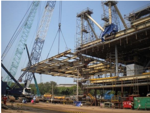
Gambar 6 Deck Stacking untuk Sub Cellar Deck
