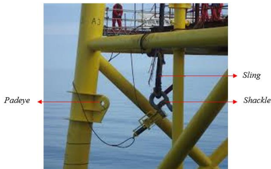
Gambar 7 Ilustrasi Sling, Shackle, dan padeye
